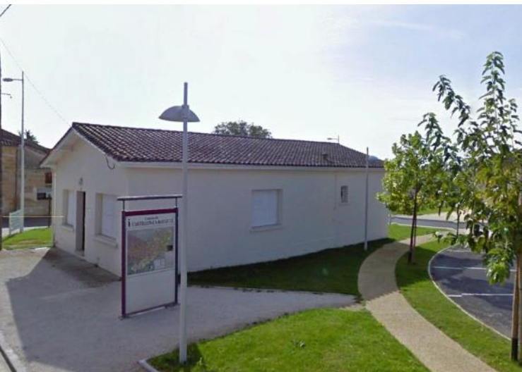
Ancienne maison des associations (démolie pour raison de sécurité)
